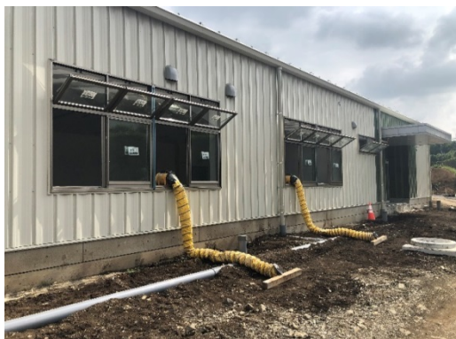
【写真②】送風機による換気(室外側)
